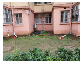
(a) 建造雨水花园
