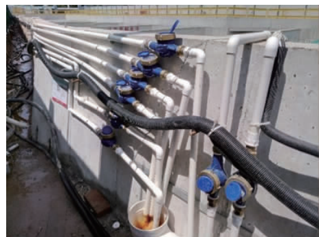
图5 降水系统管道及监测表
