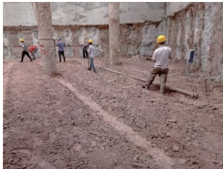
图 6 降水效果良好(坑底无明水)
