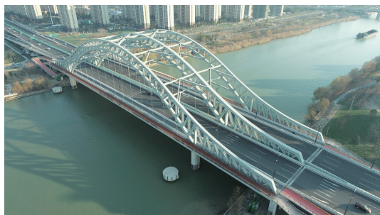
图 1 扬州江广快速路茱萸湾大桥建成实景
