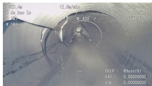
图4 管道CCTV成像结果案例图示
