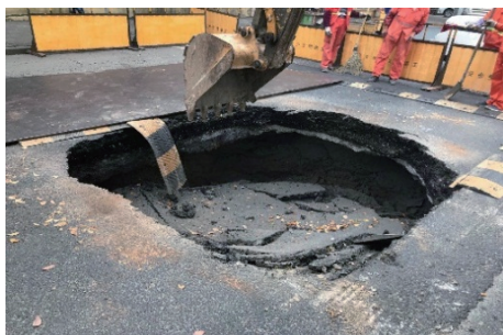
图1 现状路面板底脱空之实景
