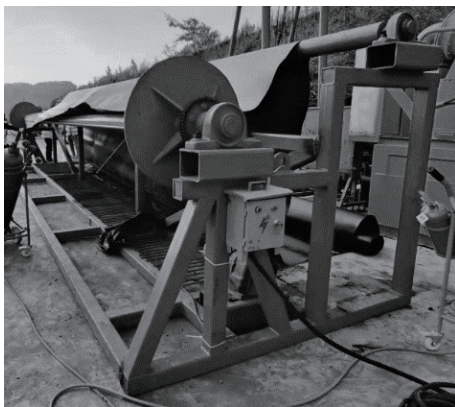
图 3 铺膜机施工图
