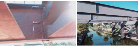
图 9 应变传感器与钢梁安装
