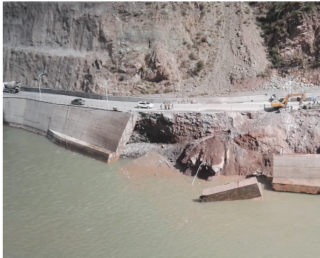
图2 洪水冲刷破坏
