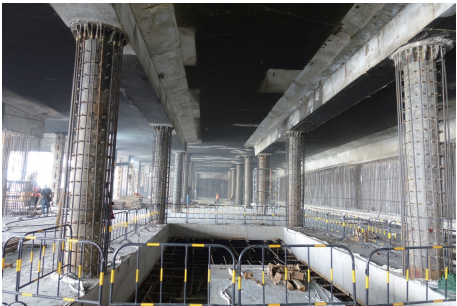
图 6 钢管柱定位效果
