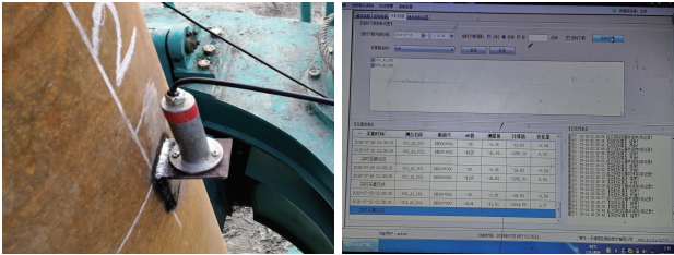
图 5 钢管柱安装过程中垂直度测斜仪实时监测
