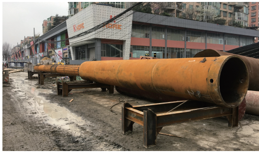
图2 钢管柱拼装
