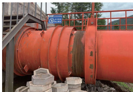
图 6 侧板与盖板裂缝(一)
