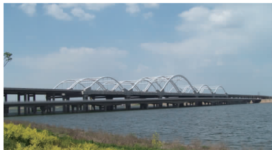
图3 灞河大桥建成图
