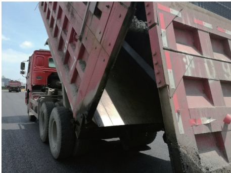
图 4 摊铺后运料车厢底无流淌现象之实景
