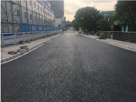
图 5 无纤维 SMA-13 沥青试验段实施效果之实景
