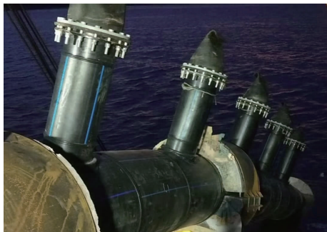
图7 扩散段管道下沉之实景
