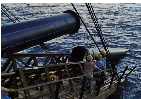
图 6 标准段管道下沉之实景
