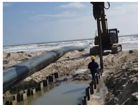
图 3 钢板桩支护之实景
