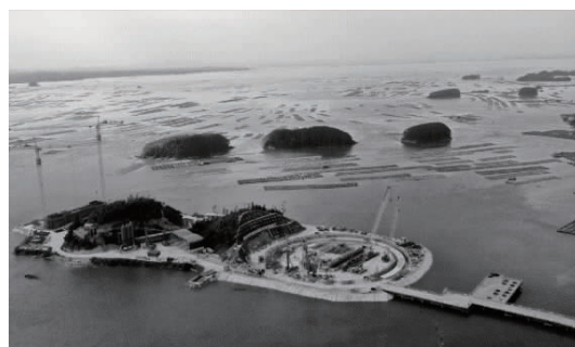
图 1 某大桥锚碇基坑施工航拍图
