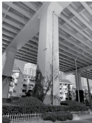
图 1 桥柱绿化现状
