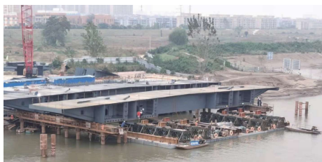
(a)浮箱进入平台,支撑钢梁
