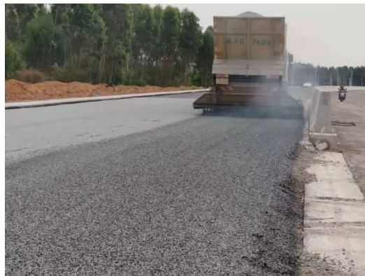
图 2 同步封层车试洒
