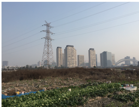
图4 现状 2# 与 3# 高压塔
