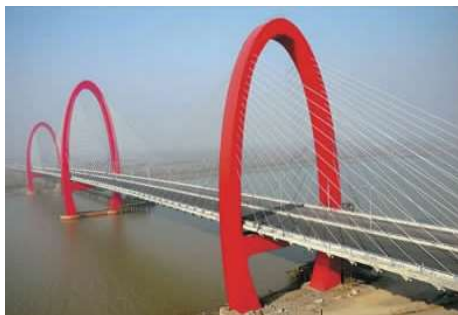
图 11 马鞍山长江大桥右汉桥
