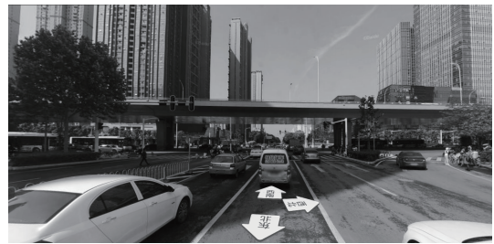
图 1 徐东高架实景图(团结大道路口处)
