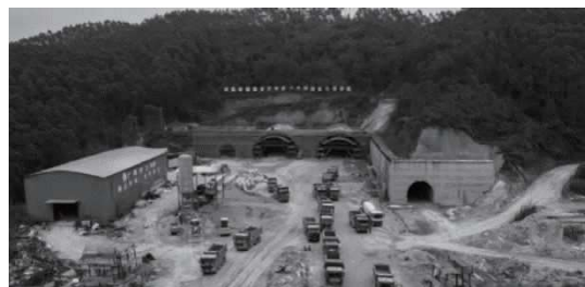
图 10 隧道现场照片实景
