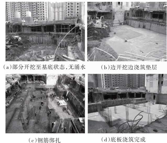
图 8 主要施工过程
