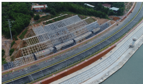
图9 高边坡完工后照片
