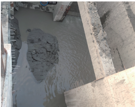
图3 沉井井内涌土现场照片
