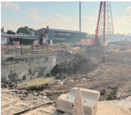
图4 沉井下沉涌土后周边场地现场照片
