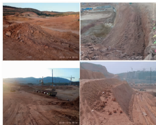
图 1 项目现场高液限土路基
