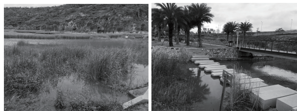
图10 中央景观湖调蓄及超标雨水溢流堰
