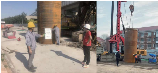
图10 钢护筒安装实例
