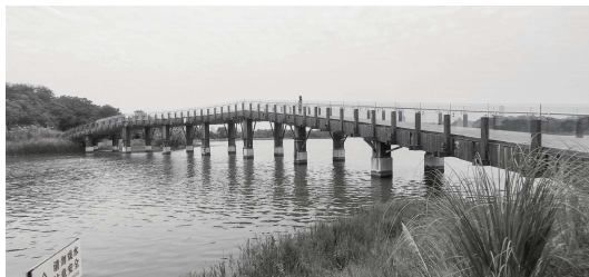
图1 揽云桥改造前照片
