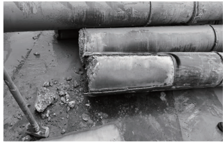
图8 拔管后底部混凝土凝结图
