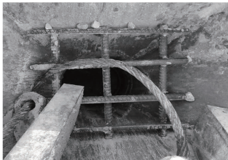
图5 防堵管钢筋网片图
