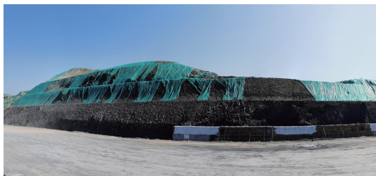
图 8 炭质页岩段边坡照片
