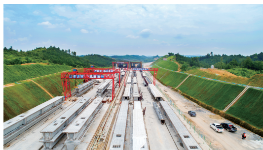
图 9 路基预制梁场全景图
