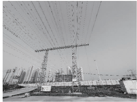
图5 低净空安全网布置
