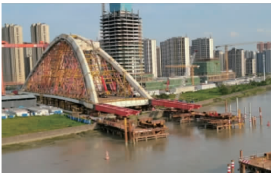
图3 新典桥整体顶推施工图
