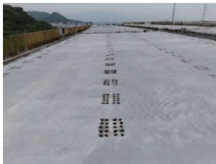
图 3 负弯矩区桥面板
