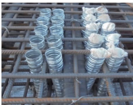
图 2 钢套筒群钉构造
