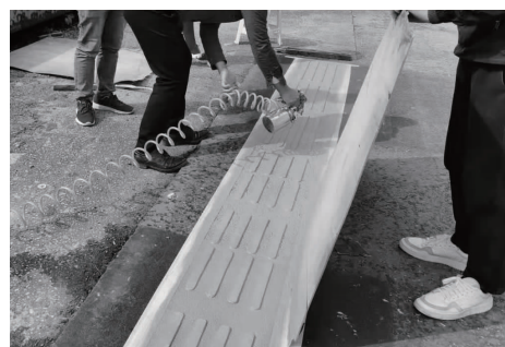
图 4 水性砂浆盲道喷涂着色
