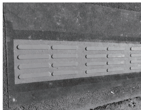
图 5 施工完成的水性砂浆盲道
