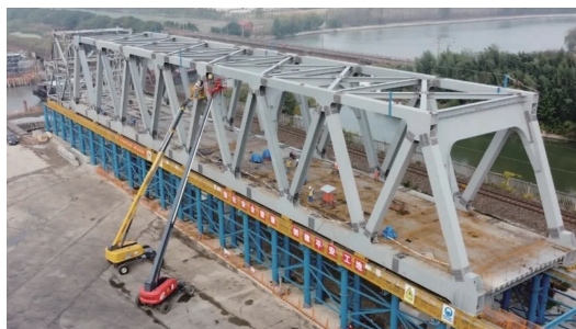
图3 钢桁梁在岸上钢支架上拼装
