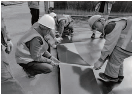
图 2 胶磁粘贴现场施工图
