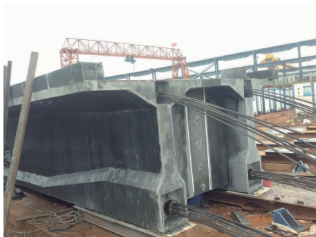
图 9 \pi 型梁成型
