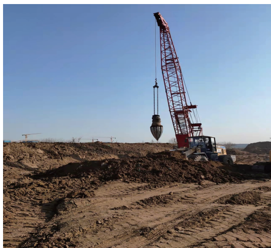
图 2 SDDC 桩施工现场
