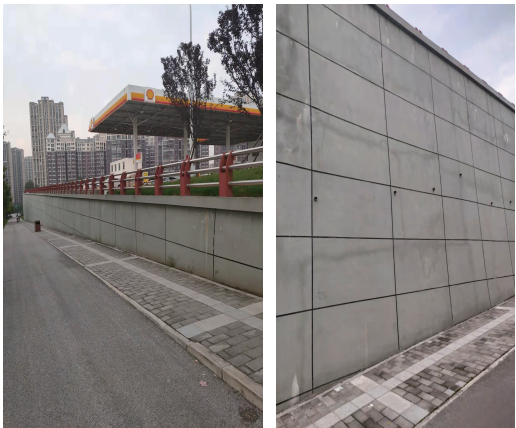
图3 排桩挡墙建成效果
