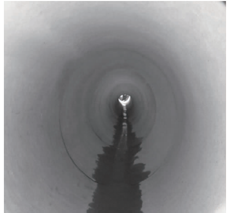
图5 排水管道顶进完成之实景
