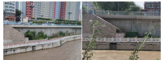
图 4 现状排河口情况
