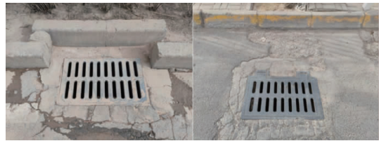
图 3 现状雨水口情况
