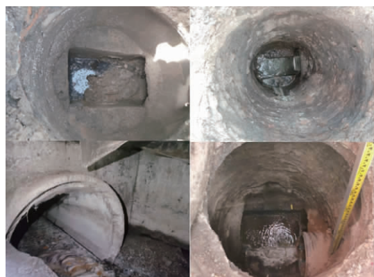
图 2 现状雨污水管道情况
