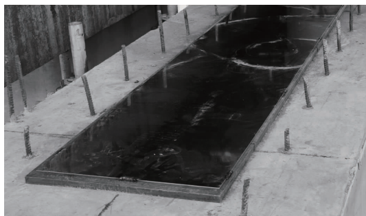
图4 滑道钢板及镜面不锈钢板现场组合使用施工照片
