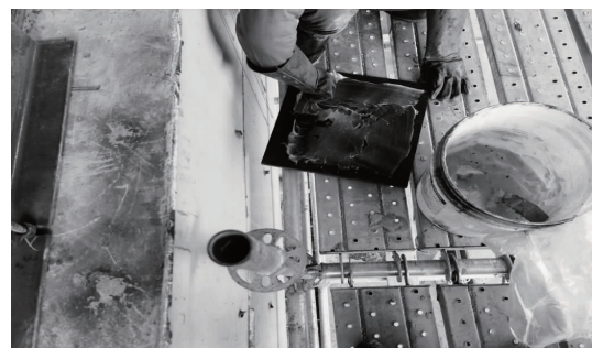
图5 UH-MGE 滑移滑板涂抹松脂油施工照片
