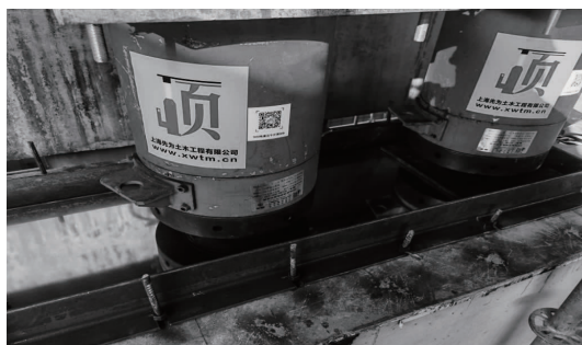
图6 平移限位施工照片
