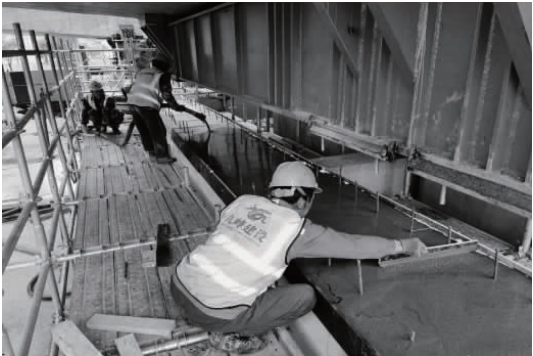
图 3 桥梁平移工程冲筋找平施工照片
