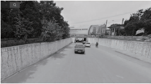
图 9 府后西街现状过铁通道
