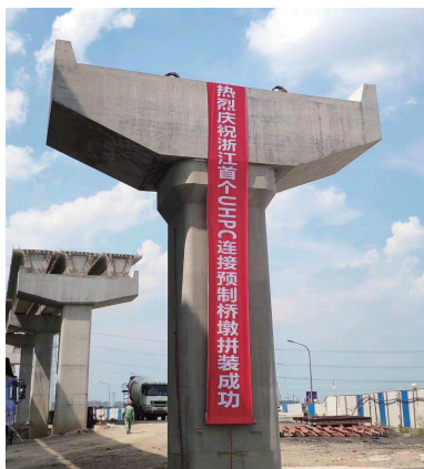
图10 桥墩 UHPC 湿接缝预制拼装
