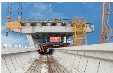
图 8 U 形轨道梁 梁上运梁
