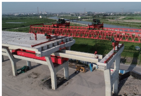
图9 上层架桥机架设下层轨道梁
