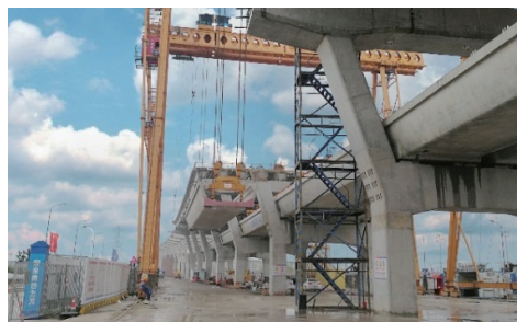
图 7 提梁站提升轨道梁
