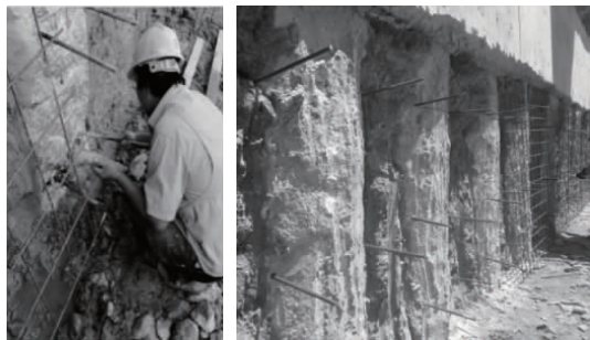
图5 拉条植筋实例图
