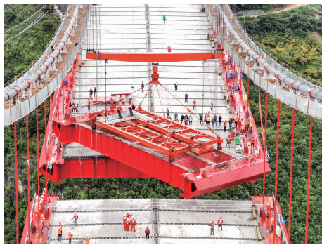
图5 加劲梁吊装
