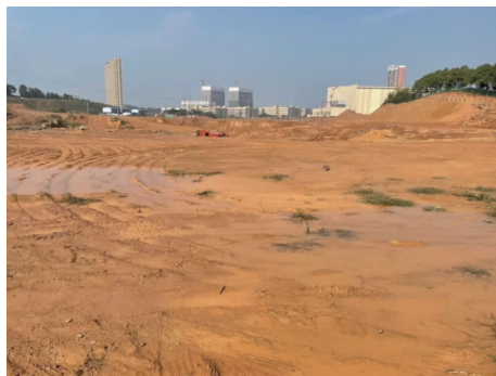
图2 梨江东六路—福祥路项目施工现场
