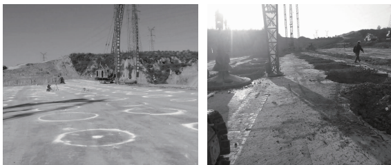
图4 分层强夯法施工现场
