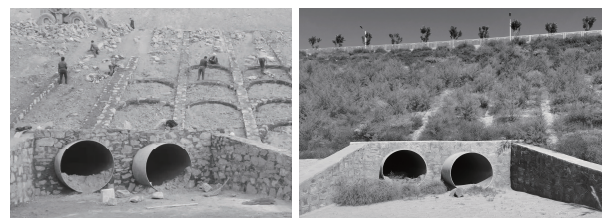
(a)护坡施工中 (b)工后2年护坡状态
