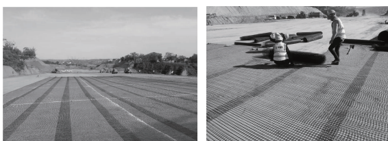
图5 基础顶部土工格栅铺设
