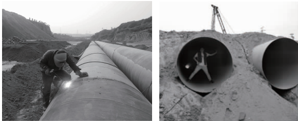
图10 基底过水管涵施工现场
