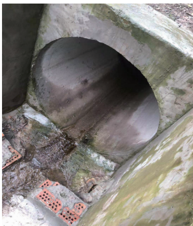
图6 排口改造前之实景
