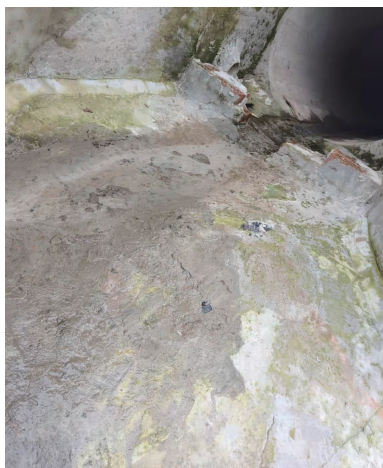
图7 排口改造后之实景
