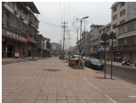
图9 安顺街雨污分流实施后之实景
