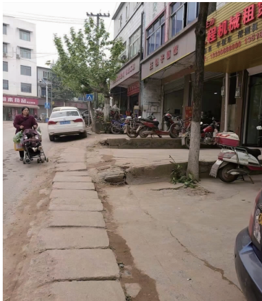
图8 安顺街雨污分流实施前之实景
