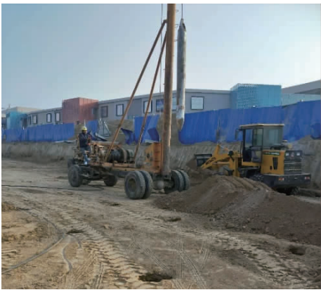
图 3 灰土挤密桩回填夯实机
