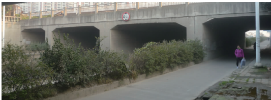
图 3 既有下穿京沪铁路立交桥
