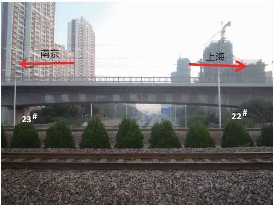
图 4 既有下穿沪宁高铁现状
