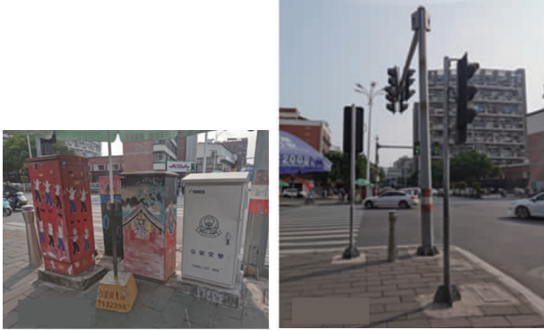
(a) 箱体过多 (b) 杆体过多 图7 箱体、杆体过多
